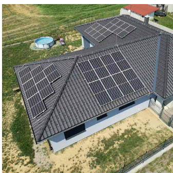
Filip S. 9,9 kWp
