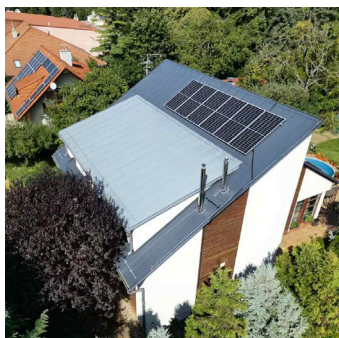
Roman B. 5,4 kWp + baterie 10,65 kWh
